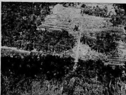
VISTA AEREA, se puede apreciar ya la carretera principal que divide las parcelas, completamente terminada y lastreada, a la derecha parte final de la moderna pista de aterrizaje 100 hectáreas listas para producir.
